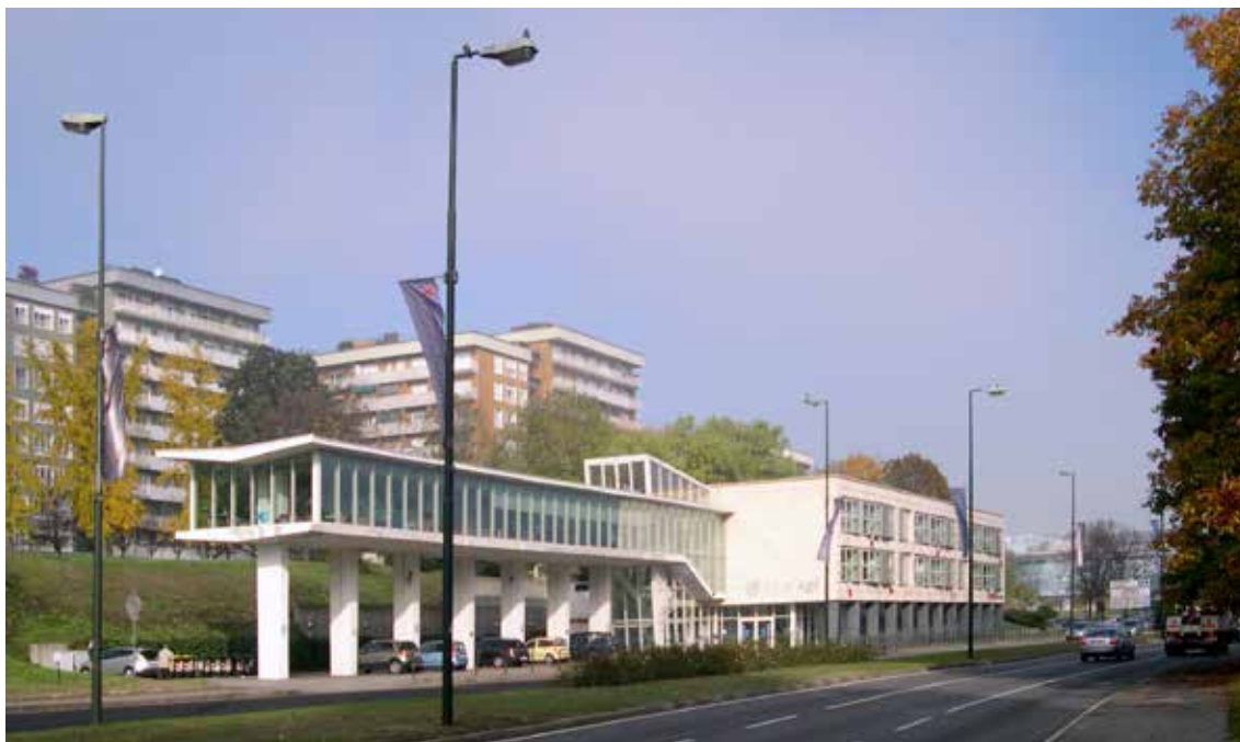
Fig. 6. La stazione Nord della monorotaia recentemente rifunzionalizzata (foto Manuela Mattone, 2011).
