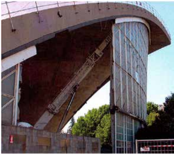
Fig. 10. Una vetrata del Palazzo a Vela in fase di smontaggio (2004).
