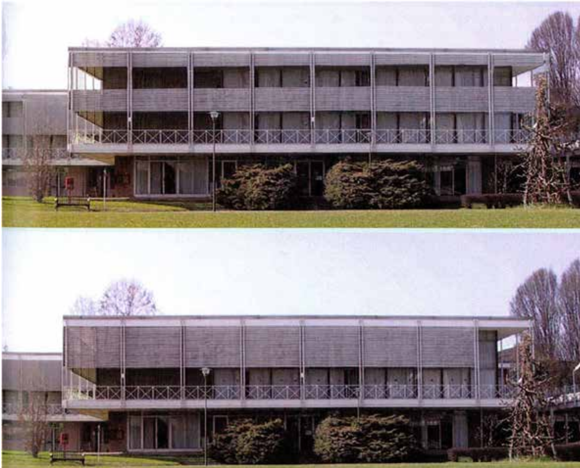
Fig. 16. Padiglioni G ed H. Confronto fra i prospetti dello stato di fatto (sotto) e di progetto (sopra) (progetto Studio Pession, capogruppo AI Engineering s.r.l.)
