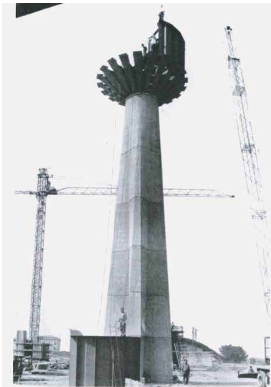
Un momento della costruzione del Palazzo del Lavoro
