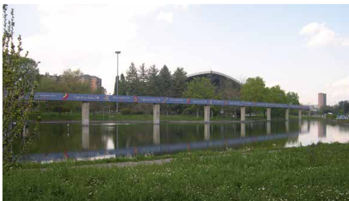
Fig. 8. I resti del tracciato veicolare della monorotaia che sovrasta il laghetto di Italia '61 (foto Manuela Mattone, 2011).
