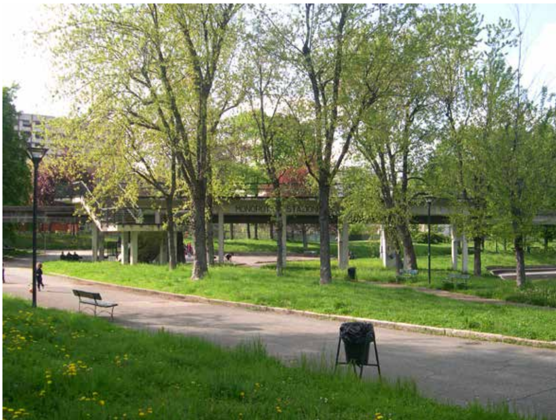
Fig. 7. La Stazione Sud della monorotaia (foto Manuela Mattone, 2011).
